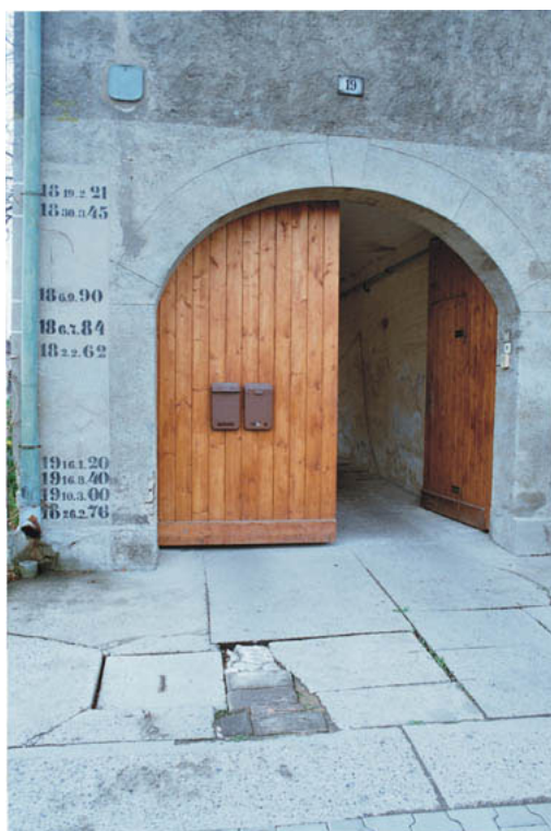
Obr. 5. Značky velkých vod v Křešicích na domě čp. 19 (foto L. Elleder). Rozhraní světlejší a tmavší barvy nad vraty indikuje výšku, do které vystoupila voda v Labi při povodni v srpnu 2002
